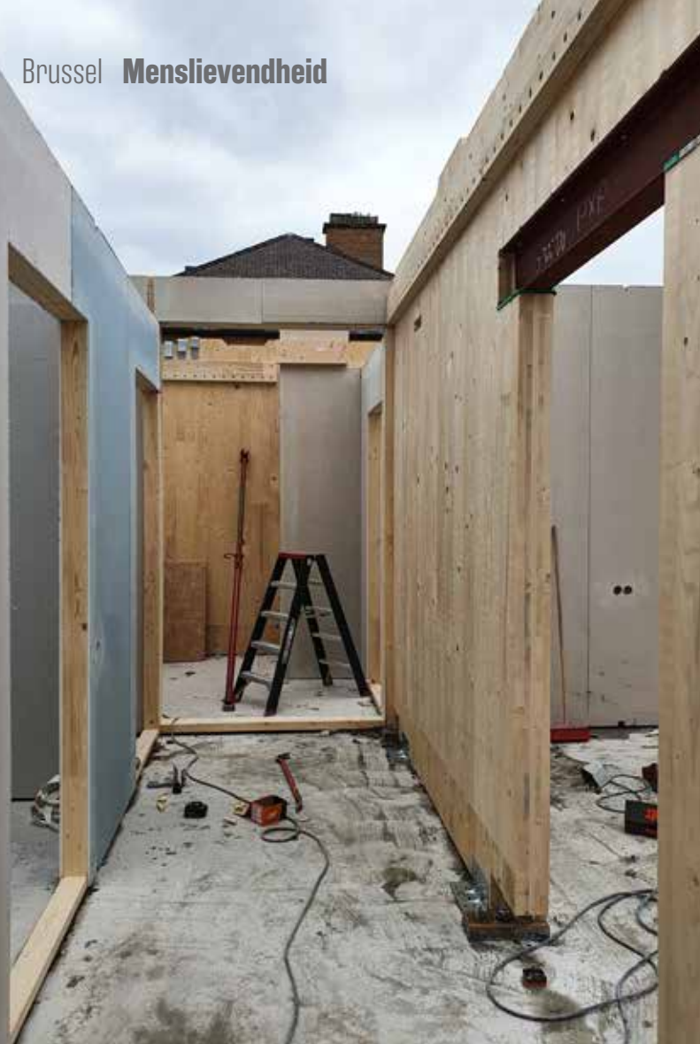
De opbouw van de houtstructuur – die circa 75 % van het gebouw beslaat – is geoptimaliseerd op basis van de levenscyclus van de gebruikte materialen.
