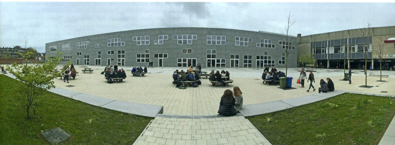
De nieuwe ruimtes kregen hun plaats tussen de bestaande schoolgebouwen.
