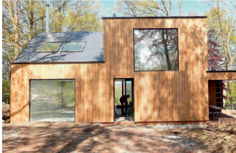
Project Coppens, Onkerzele: "Voor deze gezinswoning combineerden we staalskelet, aluminium schrijnwerk en houtskeletbouw in één enkel concept"
