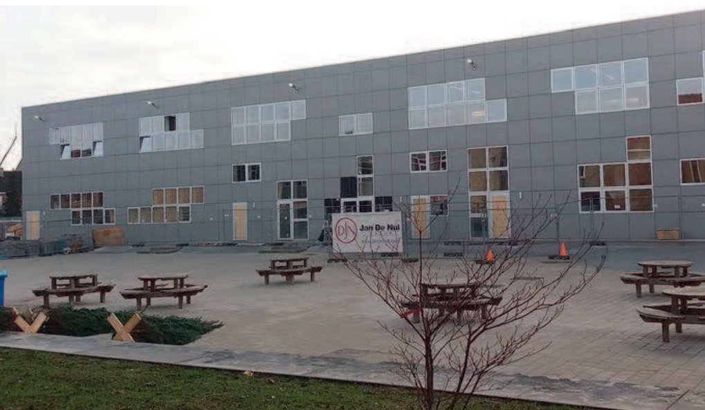
Project Emmaüsstituut, Aalter (i.o.v. Jan De Nul): "De gevel meet 110 m lang en 10 m hoog, en kent een bijzonder innovatieve opbouw. Een technisch uitdagend project dat in de toekomst navolging zal krijgen!"
