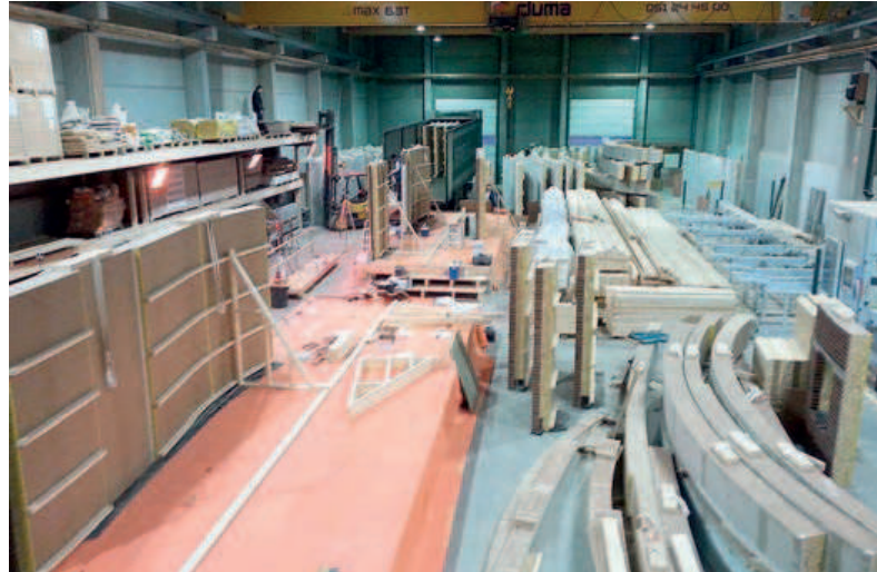
Project Avian, Gent: "We hebben alle wandelementen in ons atelier voorbereid, zodat de plaatsing op de werf slechts een minimum aan tijd in beslag nam"
