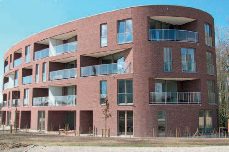
Project Avian, Gent: "Voor de ovale vormgeving van de gevel maakten we gebruik van gebogen Fermacell platen. Een waar huzarenstukje!"
